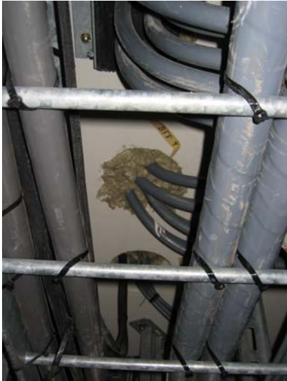
Figur 44 - gennemføring til kabelrum gennem gulv
